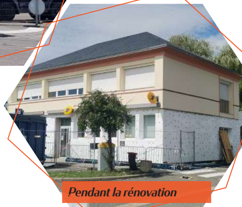
Pendant la rénovation
